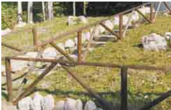
Interasse 2000 mm Montanti Ø 80 mm Traversi 40 x 80 mm
