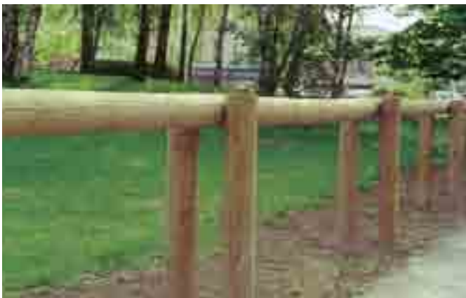
Interasse 2000 mm Montanti e traversi Ø 120 mm
